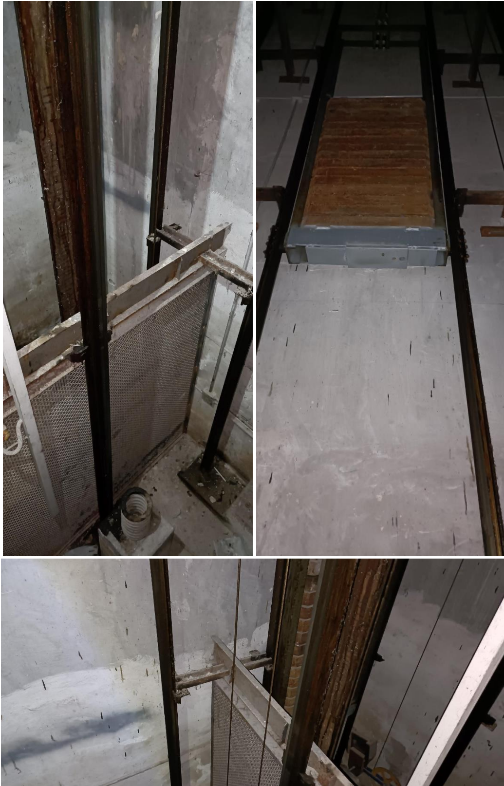
Fig. 1: vano ascensore Poliba Control
