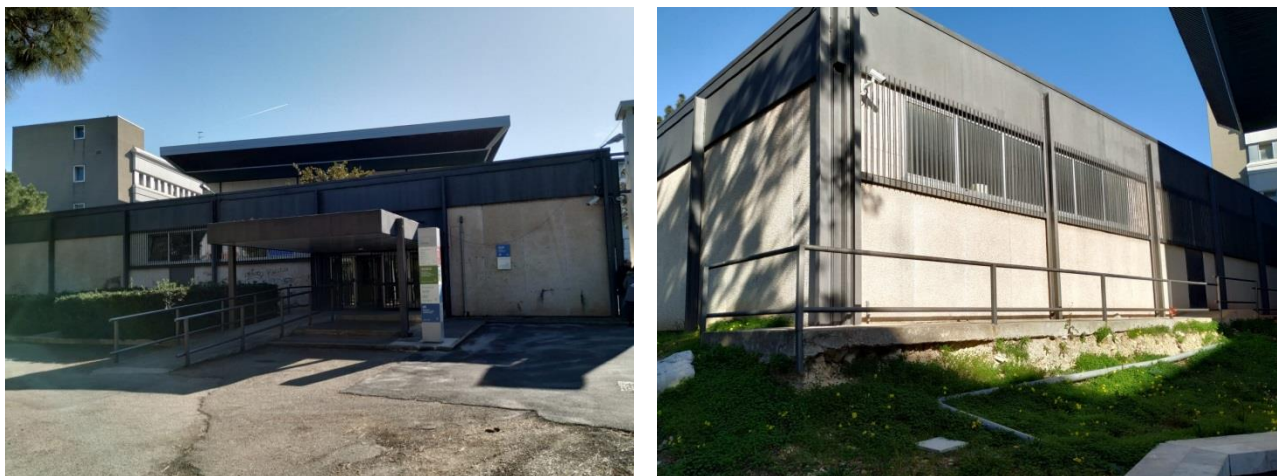
Figura 10_ Stato dei luoghi: Prospetto Nord e Angolo Sud-Ovest
